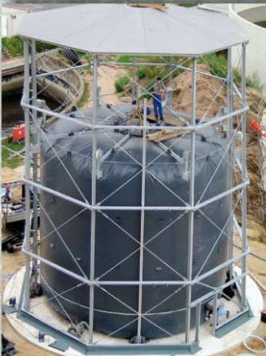
Gasspeicher (während der Montage)
