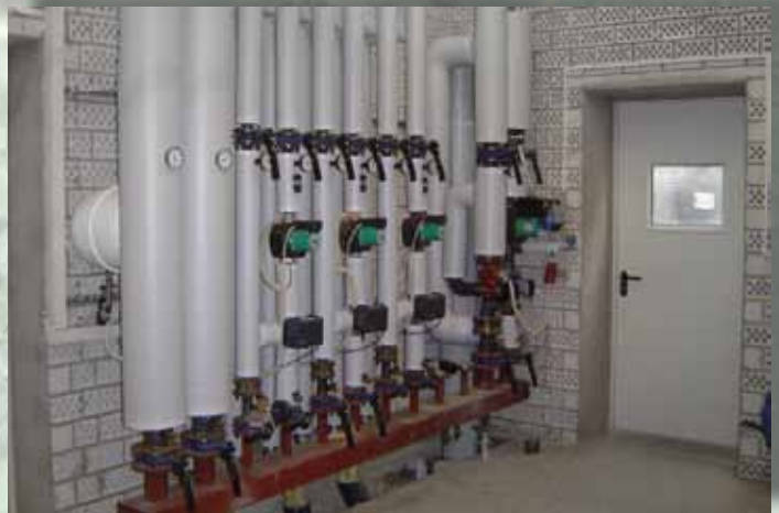
Heizungsverteiler
