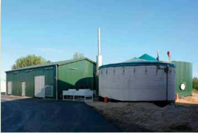
Gülespeicher neben dem Betriebsgebäude
