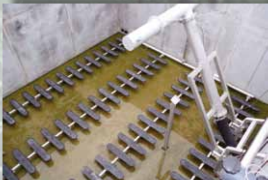
Komora reaktora SBR
