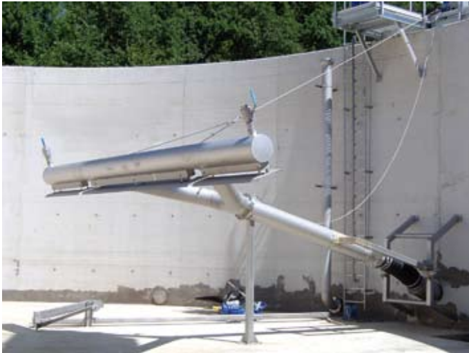
Budowa nowej oczyszczalni ścieków Huntlosen, dekanter reaktora DIC-SBR
