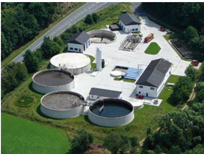
Oczyszczalnia cieków Deuz
