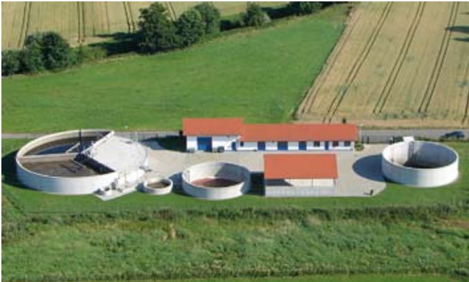
Oczyszczalnia ścieków Büdigen
