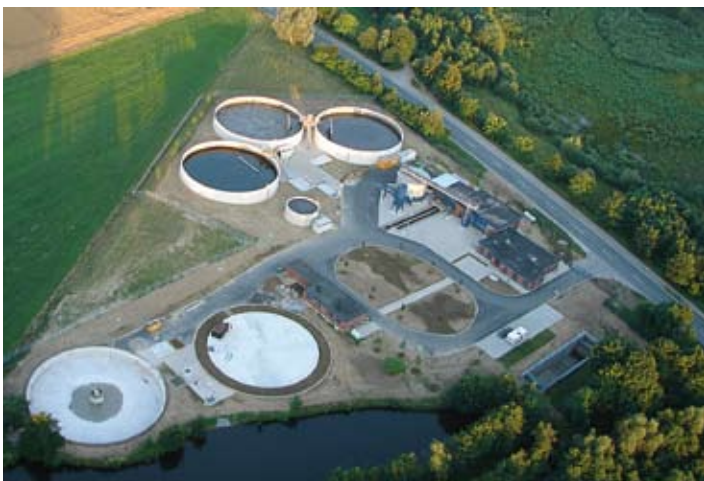
Oczyszczalnia ścieków Spenge
