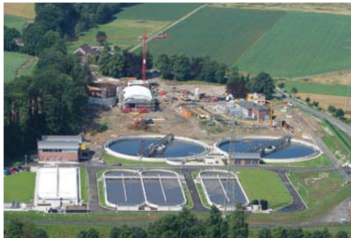
Plac budowy oczyszczalni ścieków Menden
