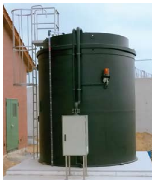
Zbiornik magazynujący Fe III przed reaktorami SBR
