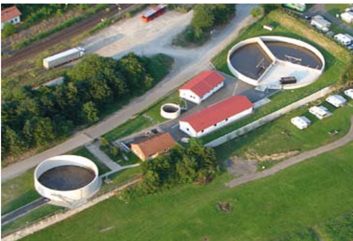
Oczyszczalnia ścieków Bad Karlshafen
