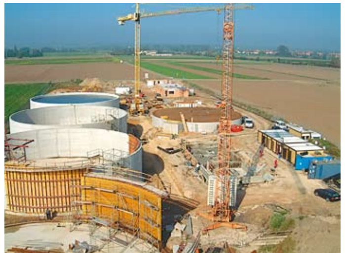
Budowa oczyszczalni ścieków Heßheim
