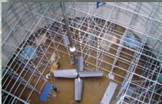
Mieszadło w komorze fermentacji (podczas montażu)
