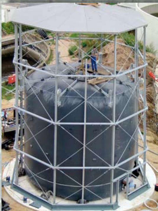
Zbiornik gazu (podczas montażu)
