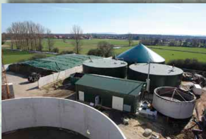
Biogazownia Sachsenhagen (częściowo jeszcze w budowie)
