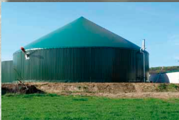
Zbiornik pofermentacyjny przykryty dachem ze zbiornikiem gazowym
